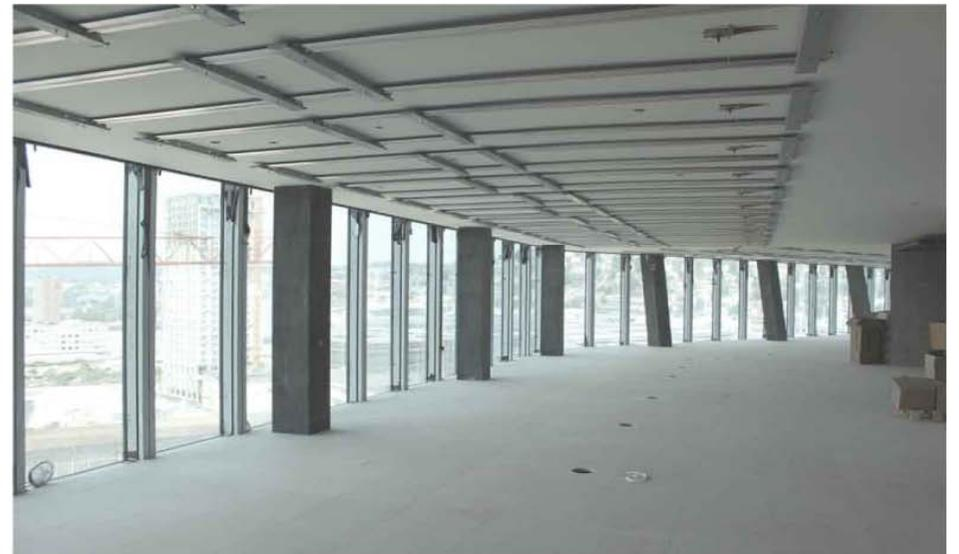
Bauzustand 10. Obergeschoss Juni 2010, Hohlboden, Deckenpaneele
