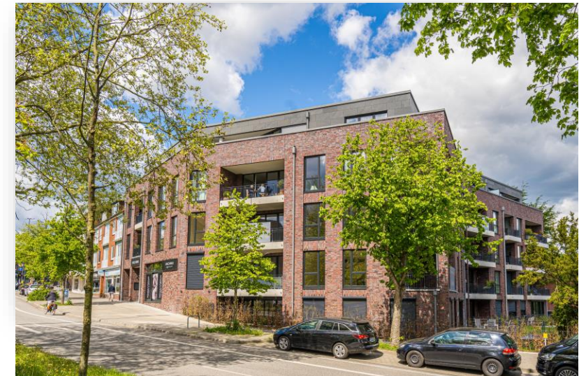
Ausgewähltes Objekt in Hamburg (D), Erdkampsweg 4,6
