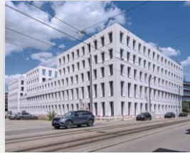
JED Neubau Zürich-Schlieren
