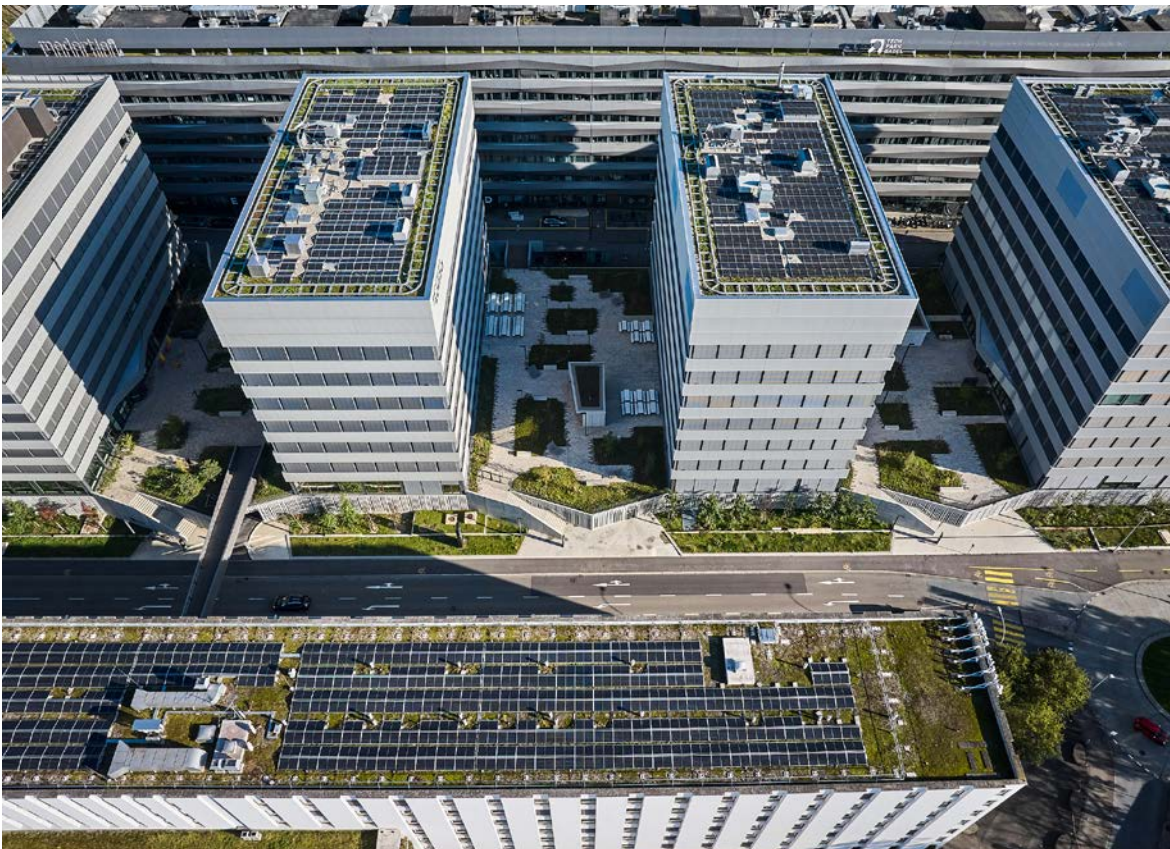
Der 2024 in Basel fertiggestellte Stüchi Park wurde nach modernsten Nachhaltigkeitsansprüchen errichtet (hier Sicht von oben auf die Photovoltaikanlagen auf den Dächern).
